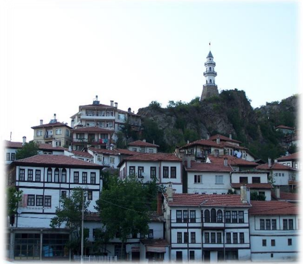
Saat Kulesi - Göynük Evleri - Göynük / BOLU
