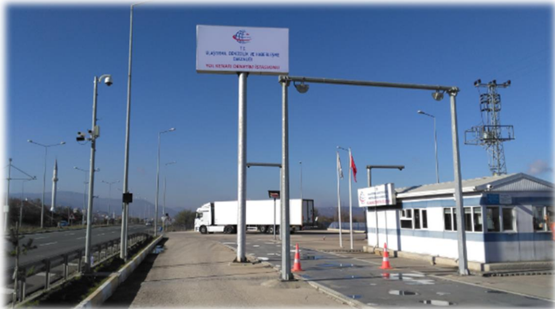
Yol Kenarı Denetim İstasyonu Yeniçağa / BOLU
