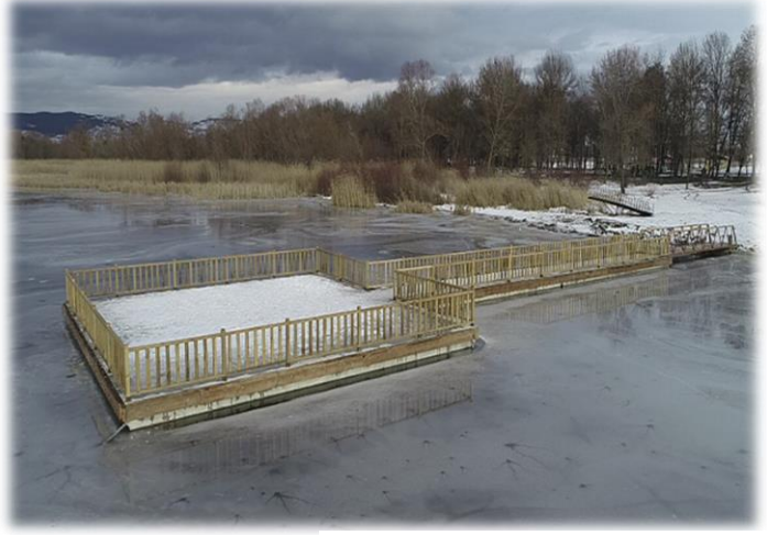
Yeniçağa Gölü – Yüzer İskele İnşaatı
