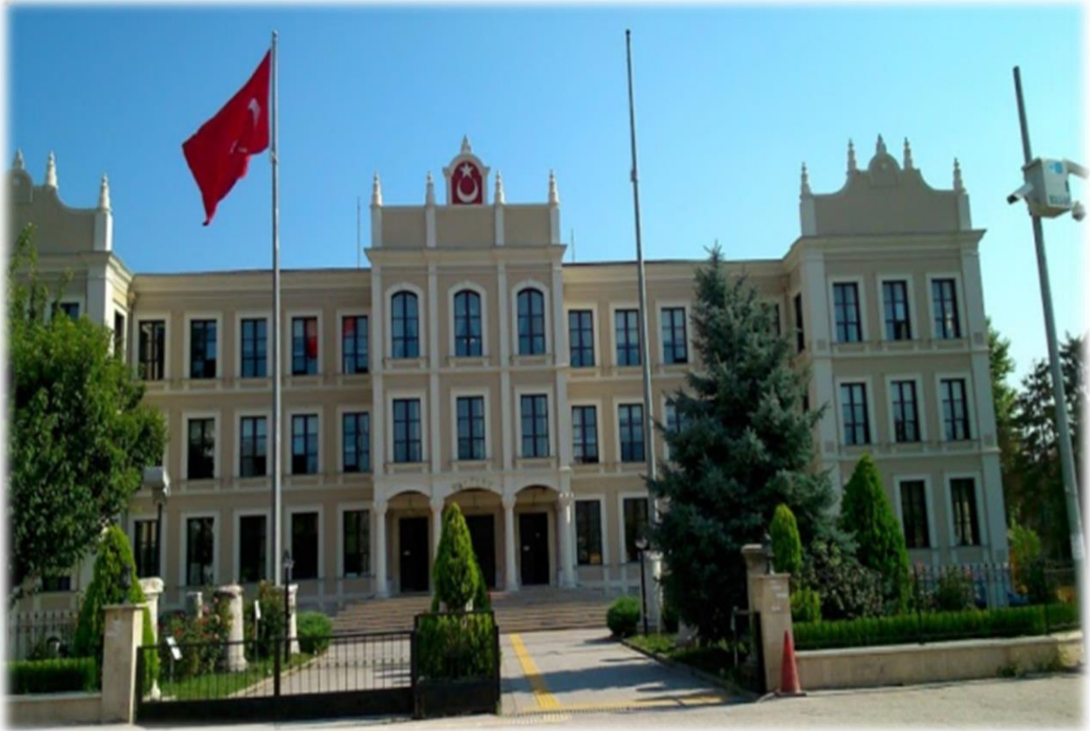
Vallik Binası / BOLU
