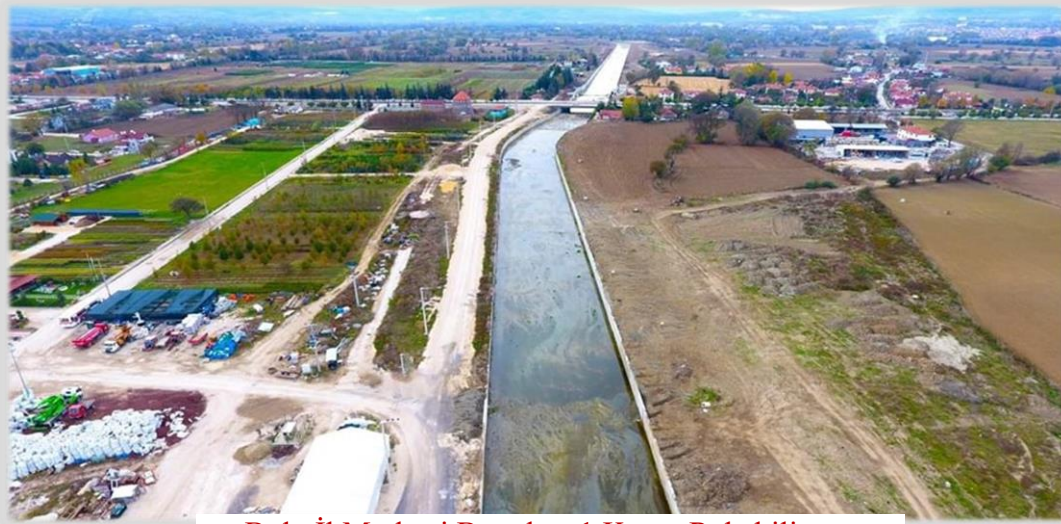
Bolu İl Merkezi Büyüksu 1.Kısım Rehabilitasyonu
