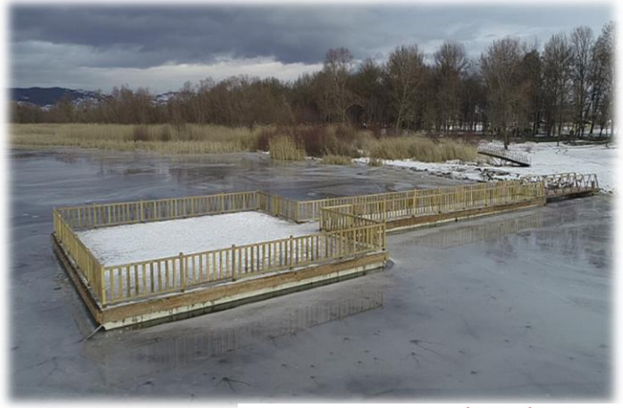
Yeniçağa Gölü – Yüzer İskele İnşaatı
