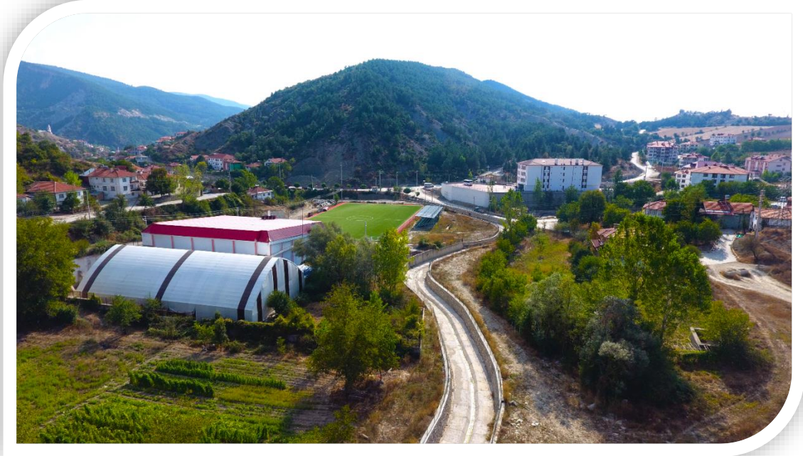
Göynük İlçe Merkezi Çaybahçe, Kemer ve Göynük Dereleri Islahı
