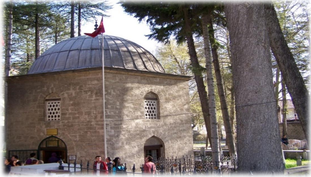
Akşemsettin Türbesi-Göynük / BOLU
