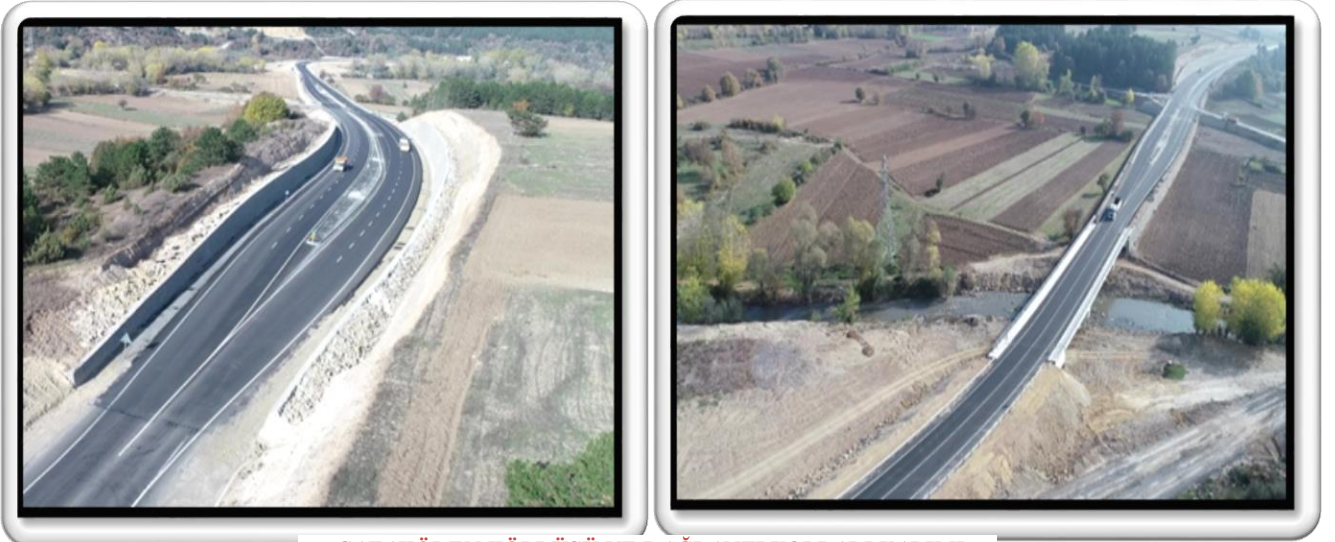
ÇATAKÖREN KÖPRÜSÜ VE BAĞLANTI YOLLARI YAPIMI
