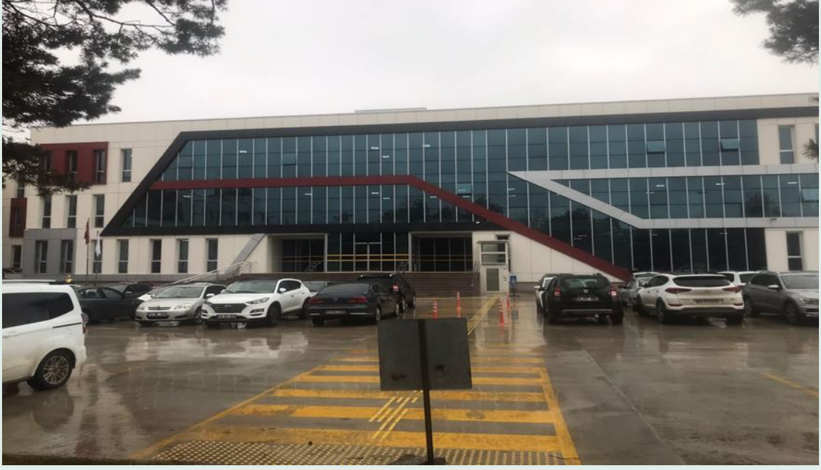
Bolu İl Özel İdaresi Ek Hizmet Binası
