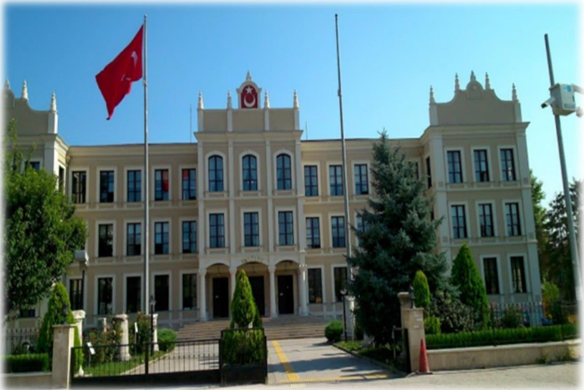
Valilik Binası / BOLU
