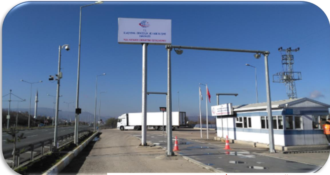
Yol Kenarı Denetim İstasyonu Yeniçağa / BOLU
