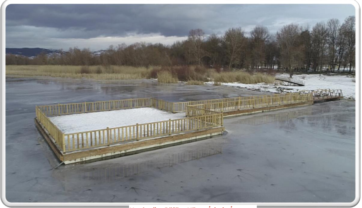
Yeniçağa Gölü – Yüzer İskele İnşaatı
