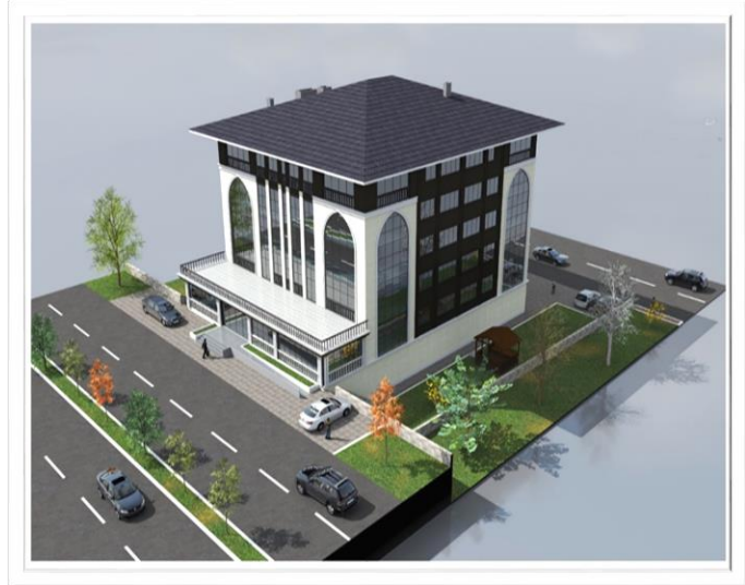
Bolu Hizmet Binası
