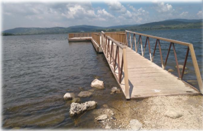
Yeniçağa Gölü – Yüzer İskele İnşaatı
