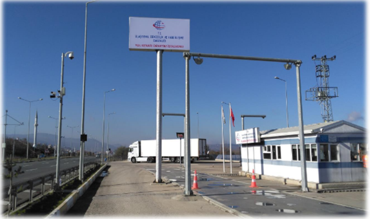
Yeniçağa Yol Kenarı Denetim İstasyonu
